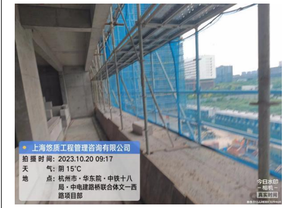
脚手架工程检查
