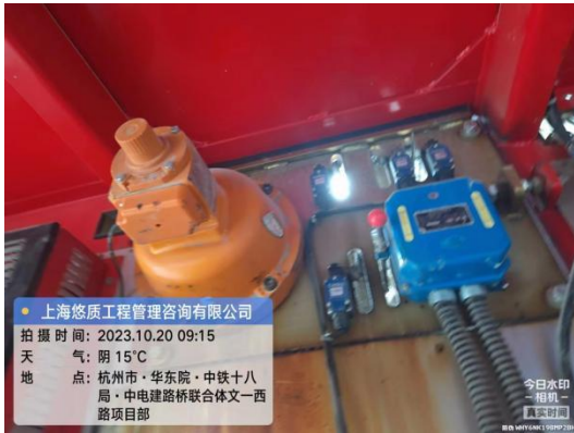
施工升降机检查
