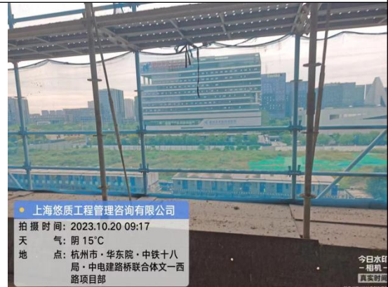
脚手架工程检查
