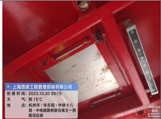
施工升降机检查
