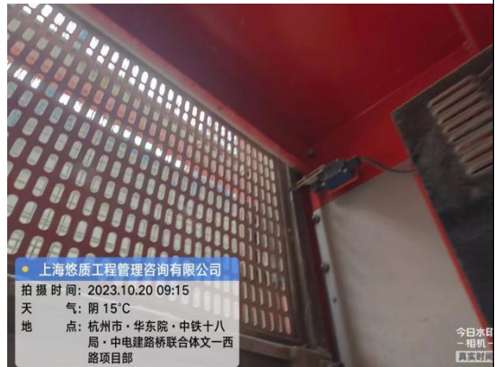
施工升降机检查
