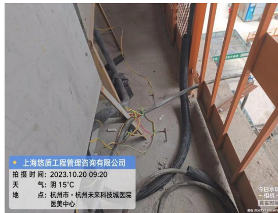
施工用电检查
