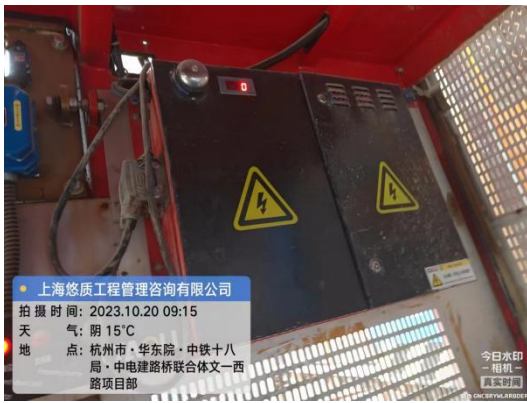
施工升降机检查
