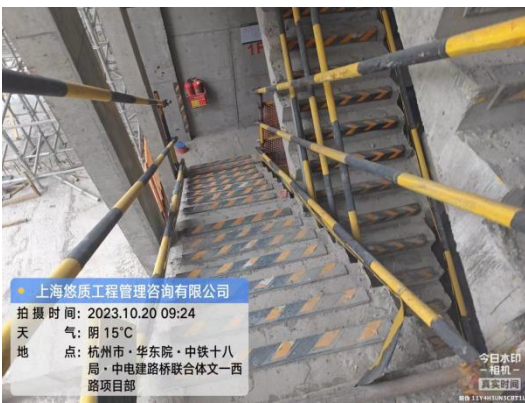
高处作业检查
