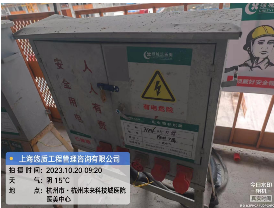
施工用电检查
