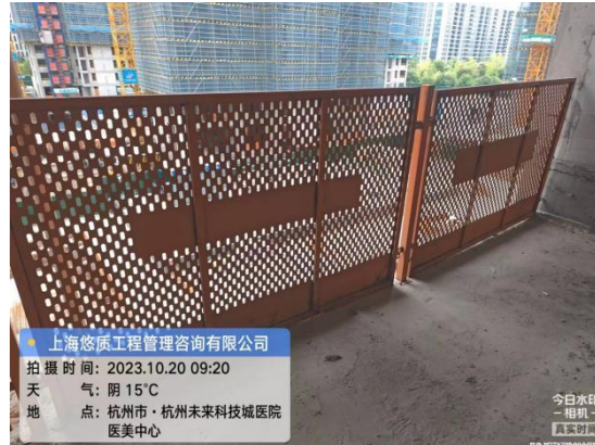
高处作业检查
