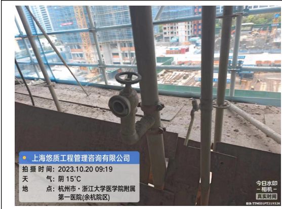
现场消防检查
