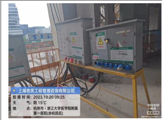
施工用电检查
