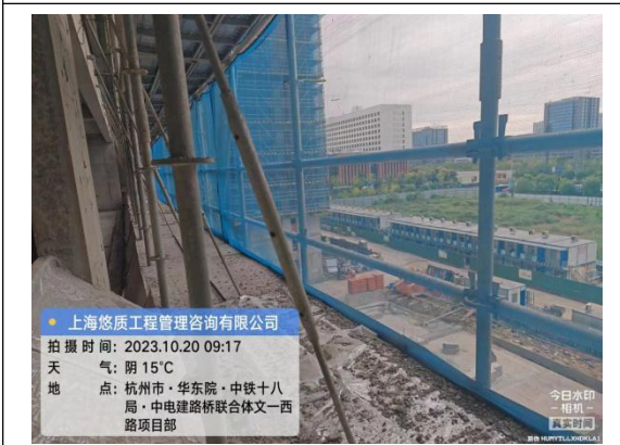
脚手架工程检查
