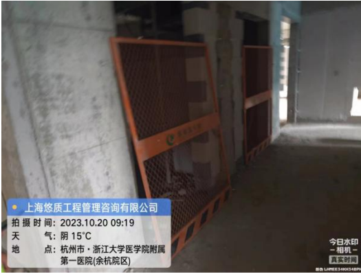
高处作业检查
