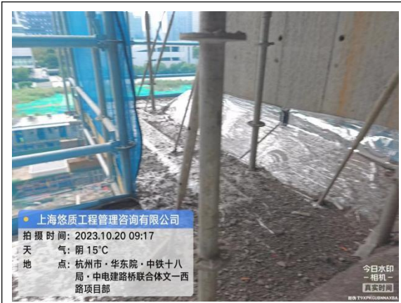
脚手架工程检查
