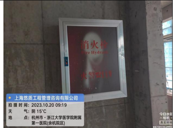
现场消防检查
