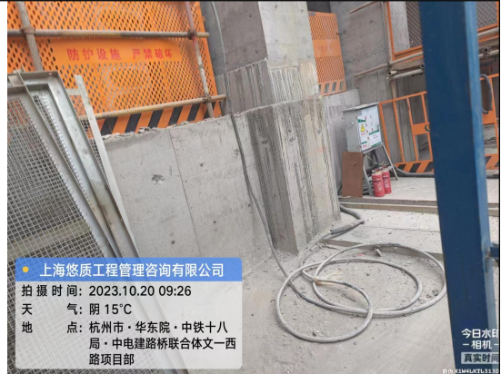
施工用电检查
