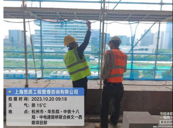
脚手架工程检查
